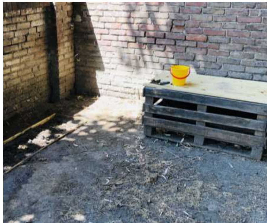
Piano d'appoggio accanto all'area scavo
