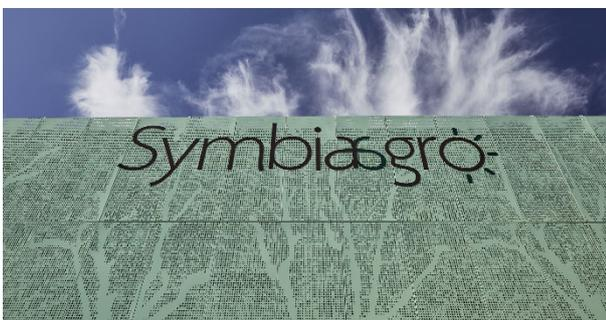
(Rivestimento fronte ovest in lamiera stirata) Il prospetto ad ovest, con affaccio sul compendio immobiliare ex C.T.R.E.A., verrà trattato con pari dignità della facciata su via San Massimo con l'utilizzo di un rivestimento realizzato con una lamiera stirata serigrafata, in modo tale da mascherare la disomogeneità prospettica dovuta alle uscite di sicurezza e nello stesso tempo garantire la permeabilità dell'involucro.
